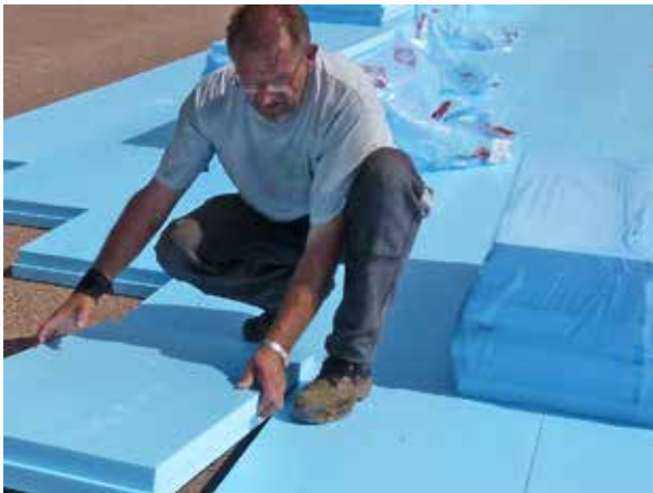
1. Tag, 11 Uhr: Die XPS-Flächendämmung ist schon fast fertig verlegt.
