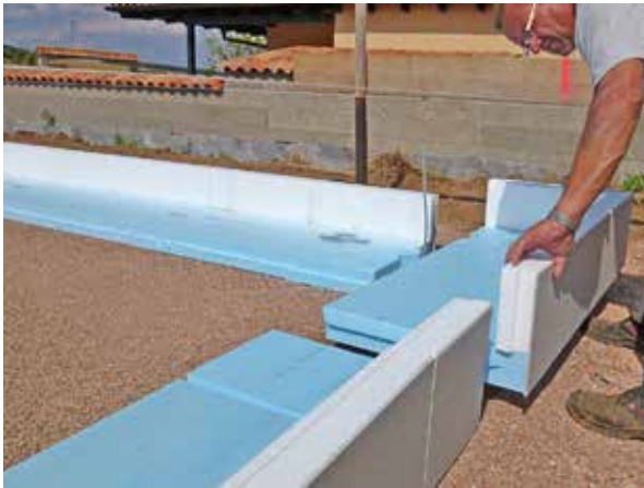
1. Tag, 8 Uhr: Los geht's mit den Schalungselementen.
