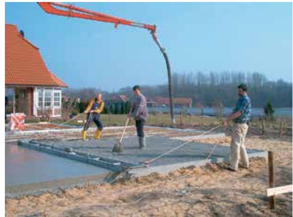
2. Tag, 11 Uhr: Betonieren und Verdichten.
