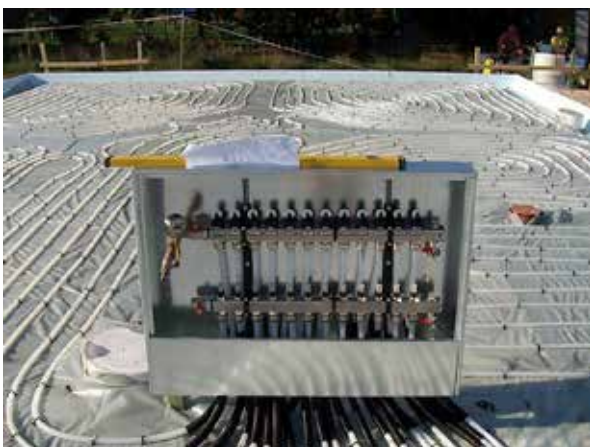
1. Tag, 17 Uhr: Die Flächenheizung verlegt und der Heizkreisverteiler errichtet.
