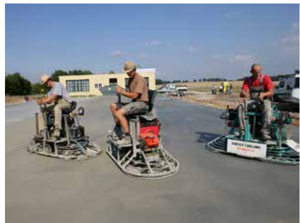
6. Jetzt wird die Betonoberfläche geglättet.
