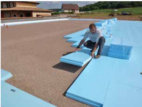
2. Es folgt die XPS-Flächendämmung.
