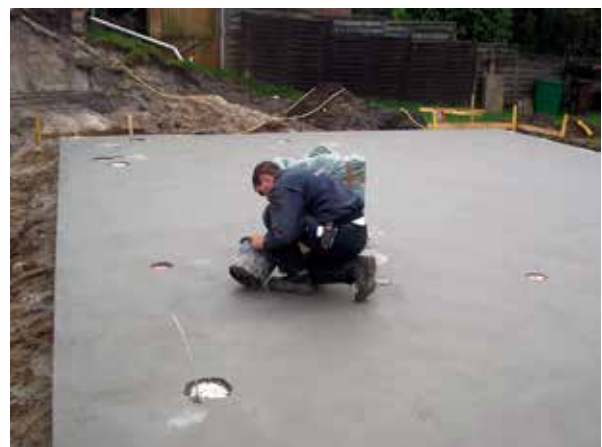
2. Tag, 18 Uhr: Die Betonoberfläche ist bodenbelagsfertig geglättet. Die FUTURA EnergieSpar-Bodenplatte ist fertig!
