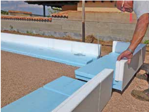
1. Die Schalungselemente werden verlegt.
