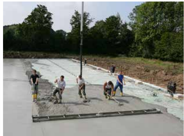
5. Das Betonieren und Verdichten der Bodenplatte geschieht quasi in einem Arbeitsgang.
