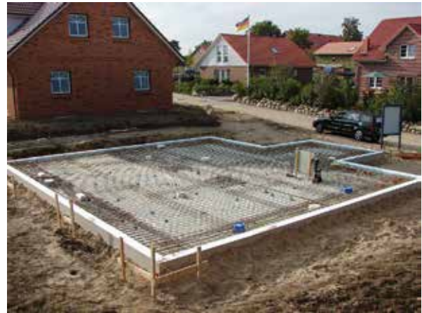
2. Tag, 10.30 Uhr: Die Bewehrung ist eingebracht.
