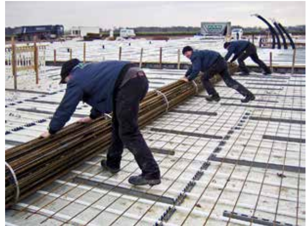
4. Bewehrung im Fundament - schwerlastfähig
